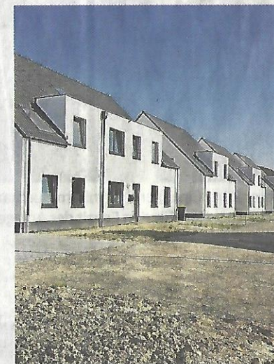
An der Fontanestraße in Schiefbahn wurden neun Häuser für Flüchtlinge mit Bleibeperspektive gebaut.
